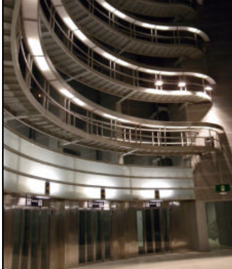
Estación nueva línea L10 del metro
